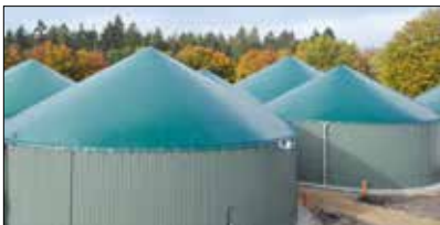
Biogasanlage Gut Hülsenberg
