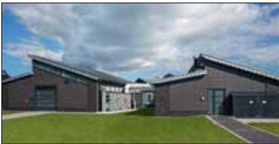
Laborgebäude und Technikum der ISF SCHAUMANN-Forschung
