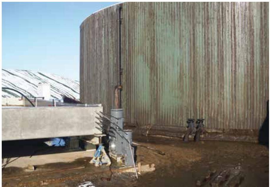
Fig.: Contenu du digesteur déversé après débordement (« effet de pâte à pain »)
