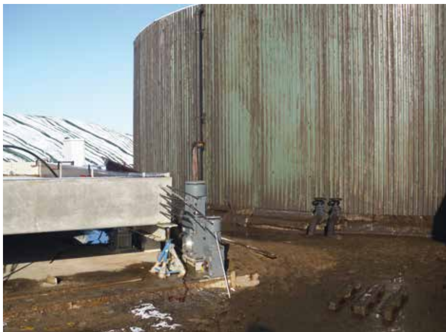
Εικ. : Χυμένο Περιεχόμενο Χωνευτήρα μετά την επέκταση (του φαινομένου "ζύμης ψωμιού")
