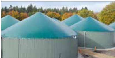
Biogasanlage Gut Hülsenberg
